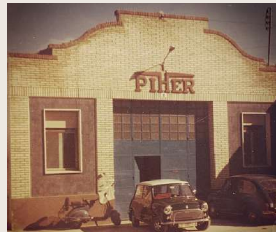
Fassade der ursprünglichen PIHER-Fabrik (Logroño, 1968)
